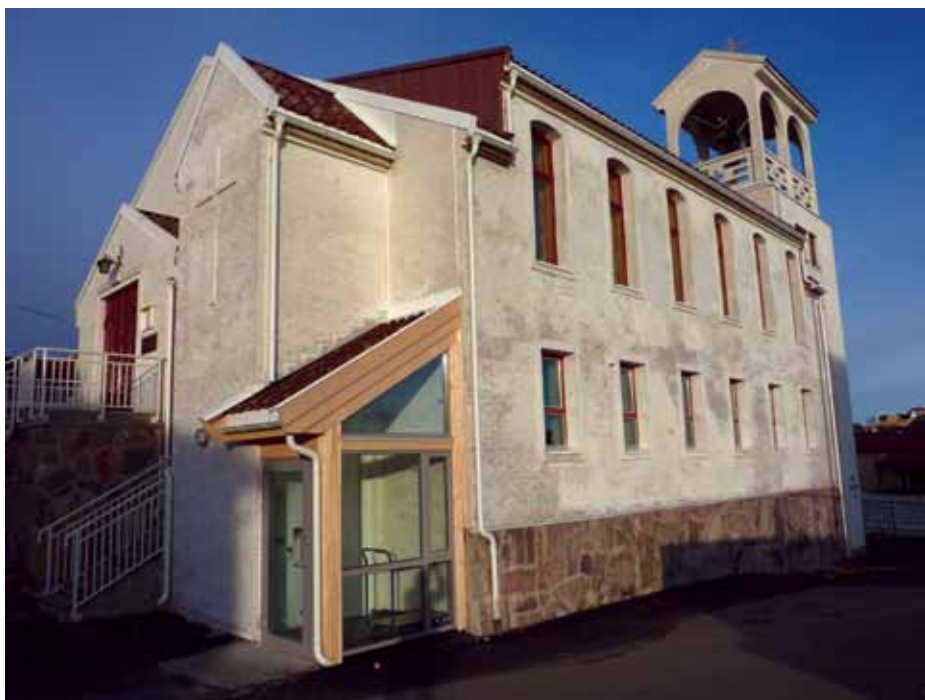
Tilbygget sett utenfra med ny handicapheis bak glassdøren, menighetskontorer i første etasje og kirkerom i annen.
